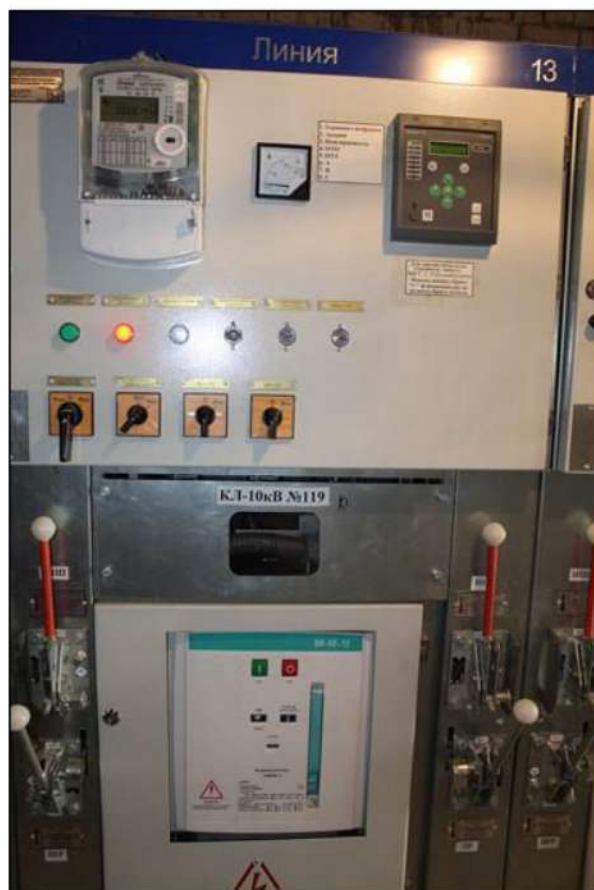
Ячейка КСО 2-10 отх. линия
