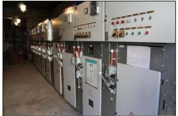
Замена ячеек КСО 202 с масляными выключателями на ячейки КСО-2-10 с вакуумными выключателями на микропроцессорных блоках РЗА МІСОМ
