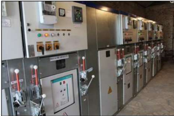
Замена ячеек КСО 202 с масляными выключателями на ячейки КСО-2-10 с вакуумными выключателями на микропроцессорных блоках РЗА МІСОМ
