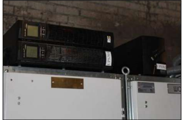
UPS для ШСН-0,4 и блок бесперебойного питания
